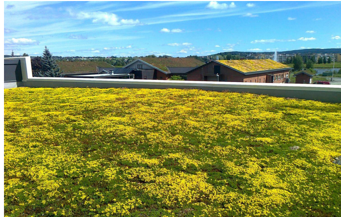
Figur 19: Ekstensive grønne tak på Nedre Romerikes avløpssekskap, Strømmen.
