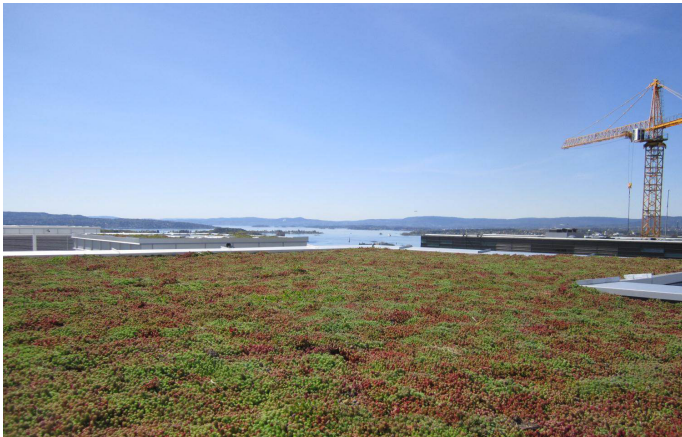
Figur 18: Ekstensive grønne tak på KLP-bygget i Bjørvika, Oslo.
