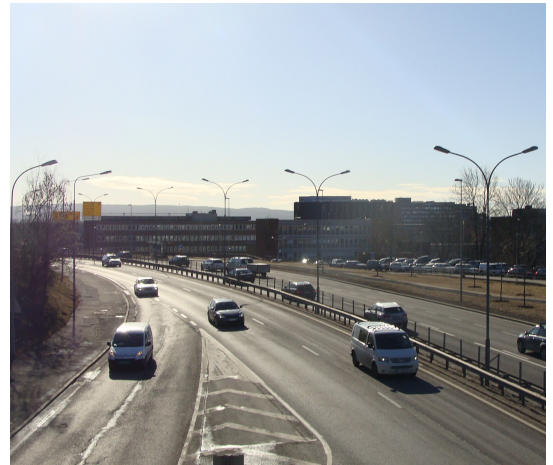
Ring 3 er en utfordring på Gaustad. Den skaper støy - og luftforurensning, i tillegg til å fungere som en barriere for bekker og grøntdrag på Gaustad.
