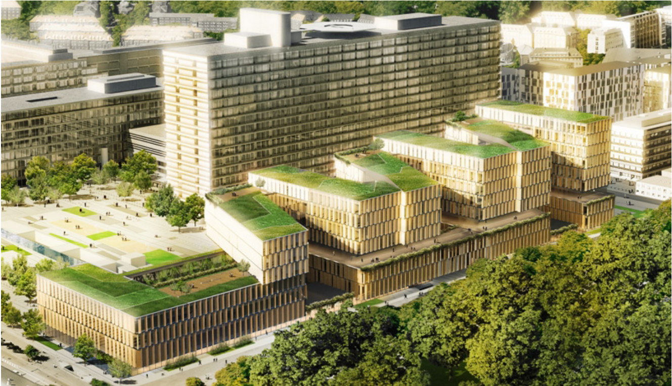
Figur 51: Oversiktsbilde av slik Nordfløyen er planlagt med ekstensive grønne tak og soner for opphold.
