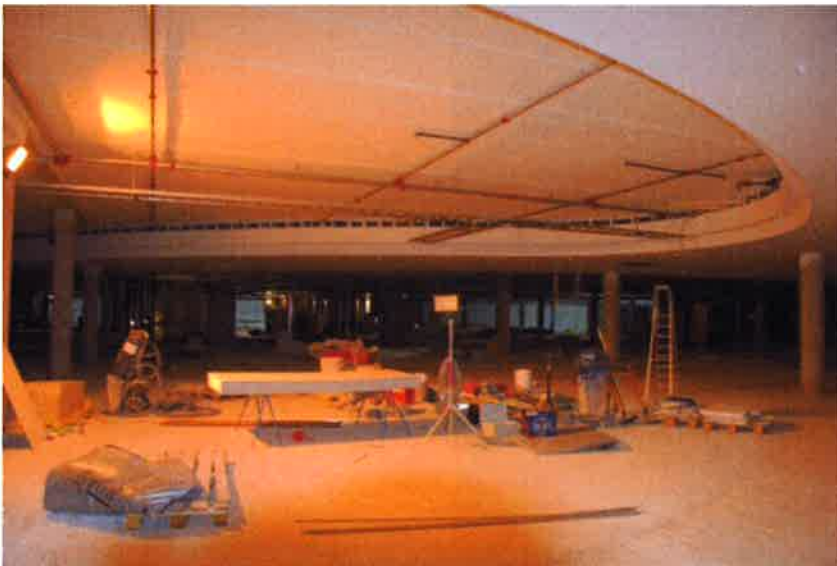
Figur 17 Bilde fra anlegget innvendig under utbyggingen
