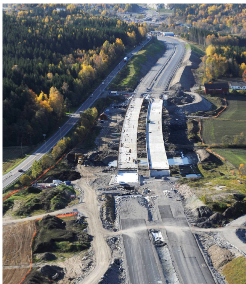
Bildet over:Arbeid med E18 Langåker-Bommestad. (Skanska 2008).
