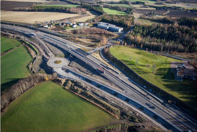
Bildet over:Konstruksjon av Tassebekkrysset - E18 Gulli-Langåker. (Vegvesen 2013p).
