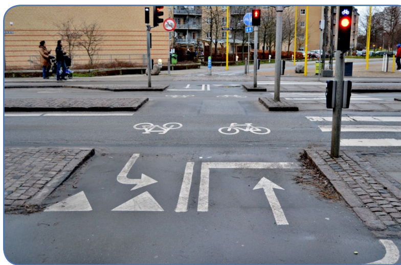
Bilde 31: TYDELIG KRYSSLØSNING FOR SYKLISTER. Parallelt med fotgjengerfeltet har syklisterne egen overgang og lyskryss.
