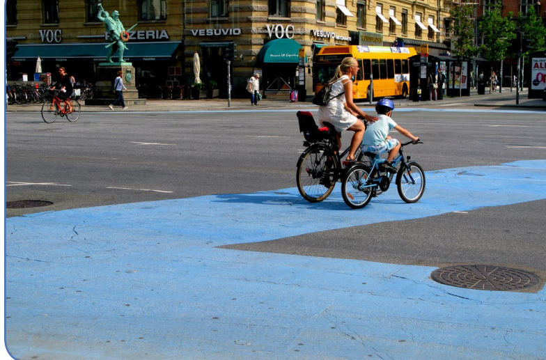
Bilde 30: BLÅ KRYSS: Blåfargen markerer sykkelstiene og bedrer synligheten.
