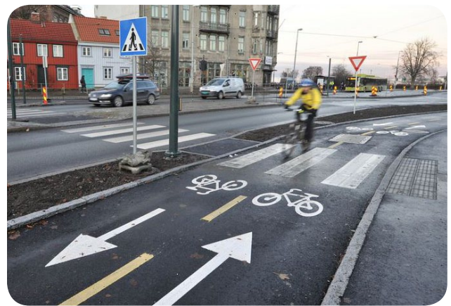
Bilde 15: SYKKELVEI MED FORTAU. Ila i Trondheim.
