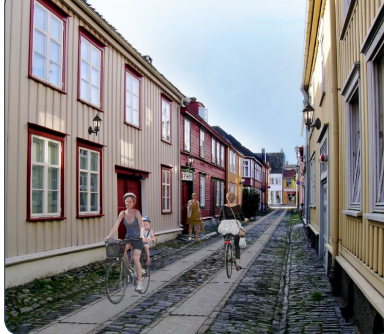
Figur 61: NY UTFORMING I DRILLVEITA: Steinheller er lagt inn i gatesteinen for å kunne sykle komfortabelt i veitene, uten at man ødelegger den karakteristiske utformingen.
