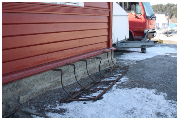
Figur 3.14: Sykkelstativ, bulket etter påkjørsel.
