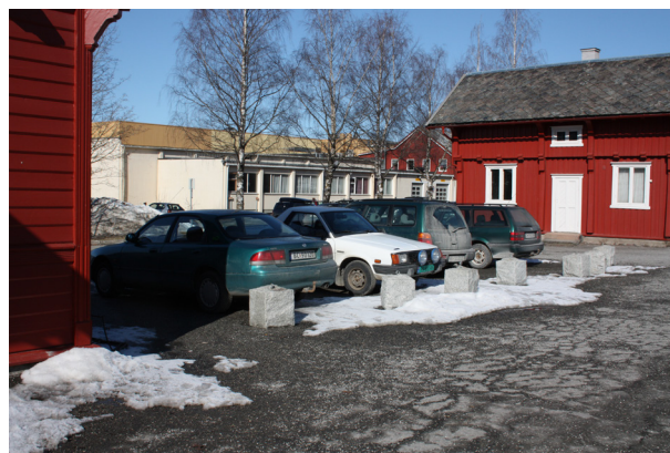
Figur 3.12: Beleggets dårlige tilstand.
