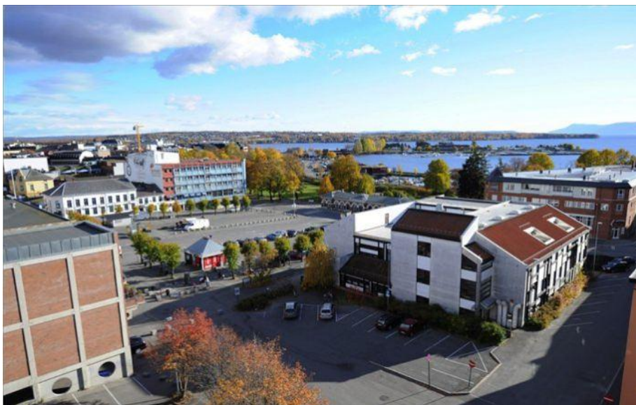
Figur 34: Bygningen til venstre i bildet er Hamar Bibliotek som ble revet i forbindelse med klargjøringen av tomten til kulturhuset (Frilseth 2010).
