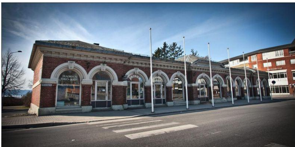
Figur 25: Basarbygningen fra 1896 danner den sørlige avgrensningen av byrommet ved Stortorget.
