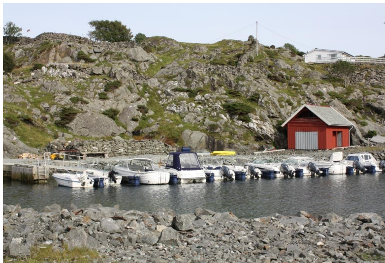
Figur 33: Part C4 sitt naust, flytebrygga til part A4 og Hjalmarnaustet til part B4 (Bilde tatt av Michelle Andersson, 28.08.12)
