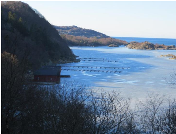
Figur 17: Oversiktsbilde over flytebryggeanlegget sett fra parkeringsplassen (Bilde tatt av Eirin Bjørnarsdotter Bø, 20.02.13)
