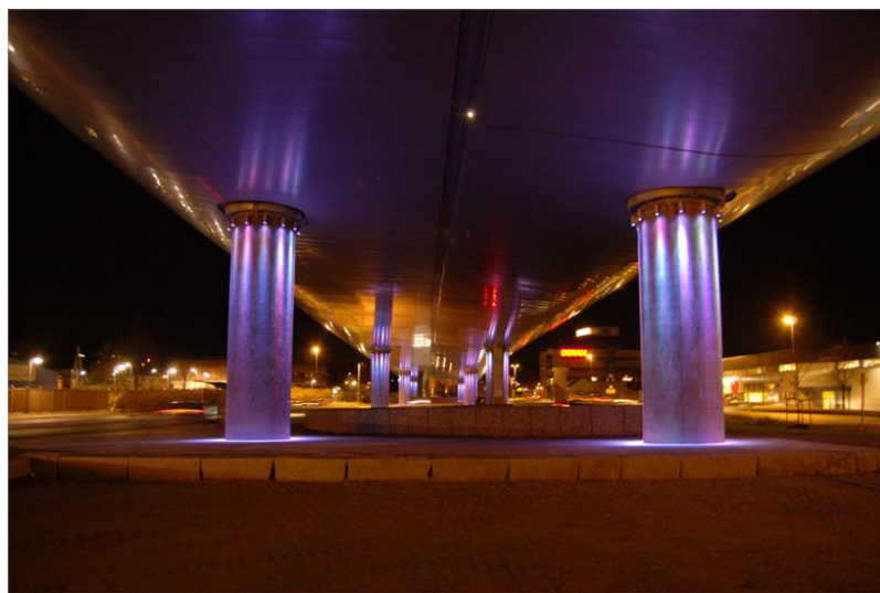
Lyssetting av Drammensbrua på kveldstid
