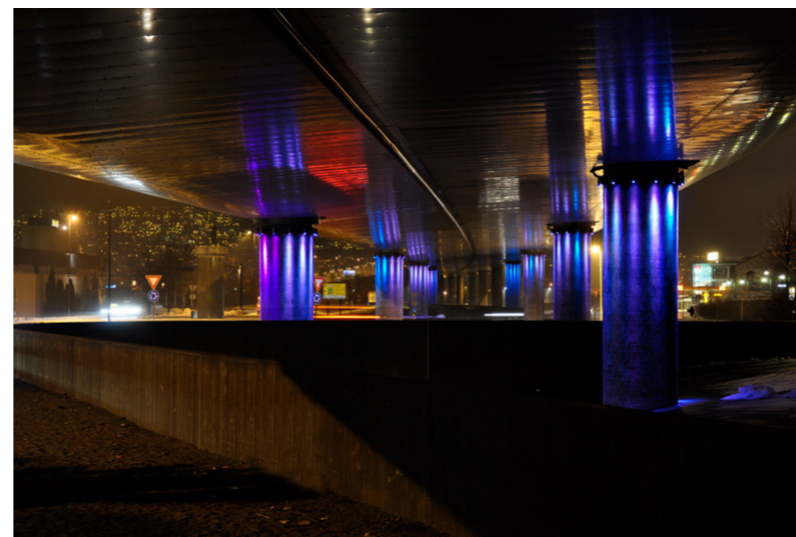
Lyssetting av Drammensbrua på kveldstid
