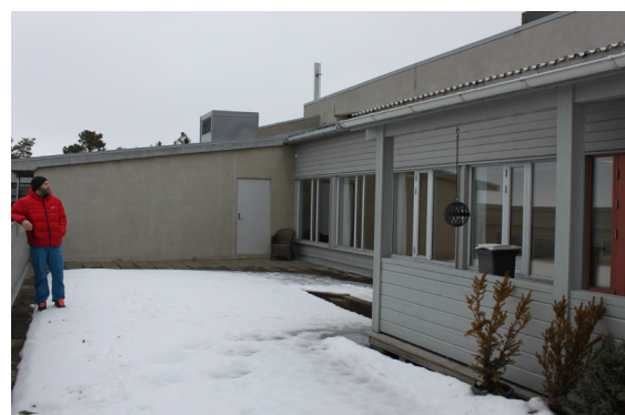
Takterrasse, mot nord. Foto: Hedvig G. Olsen
