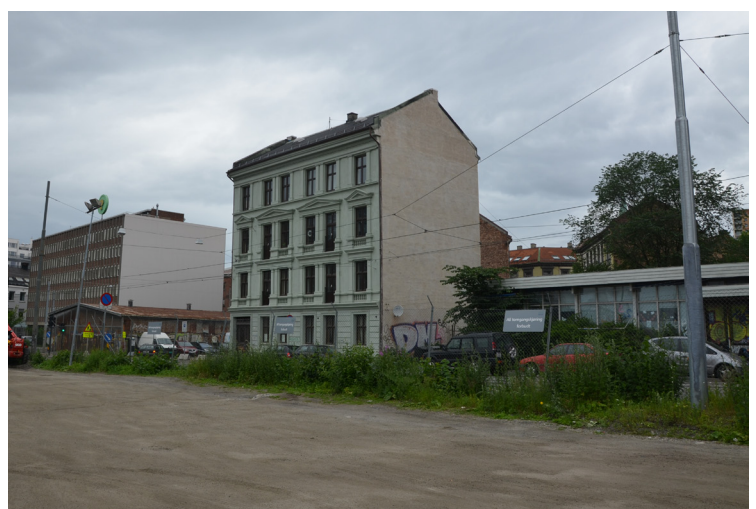
Fig 4.28 Viser den utbedrede forbygningen i Schweigaardsgate 44. Til høyre og venstre for denne ses den midlertidige bebyggelsen i Schweigaardsgate 40 b (t.v.) og 46 (t.h.) (foto: Ruud 2013).
