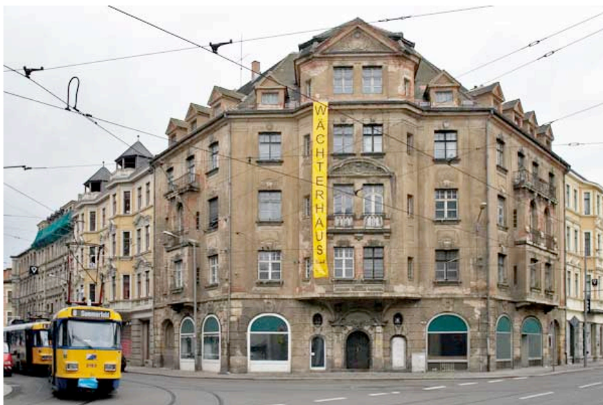
Figur 6: Viser et eksempel på et vokterhus som er blitt tatt i bruk midlertidig
