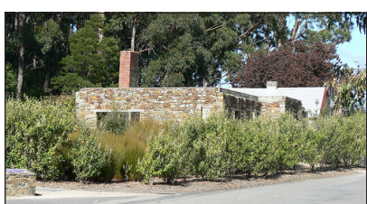
Bilde 3.62 (over): Ruinene av kafeen er godt skjult av vegetasjonen.
