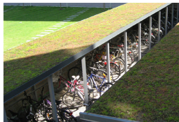
Bilde 128: Sykkelparkering under (grønne) tak.
