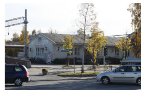
Bilde 68: Stasjonsbygget sett fra torget mellom Heimdalsvegen og Ringvålvegen.
