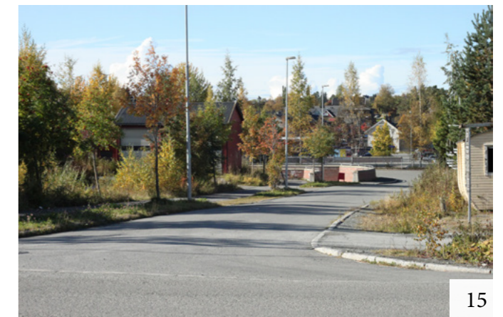
Bilde 25: Fotgjengerundergangen på østsiden av jernbanen sett fra Industriveien. I bakgrunnen kan man skimte bygninger som ligger langs Ringvålvegen.
