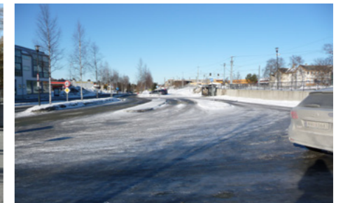
Bilde 65: Busstasjonen med dårlig tilrettelegging for fotgjengere.
