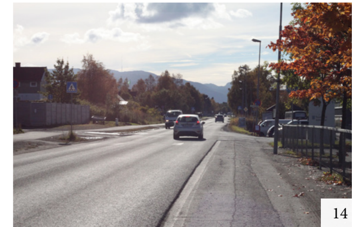
Bilde 24: Sørover langs Industriveien.
