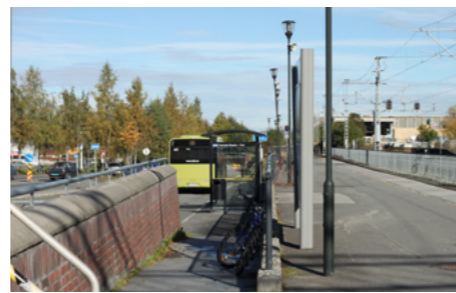
Bilde 57: Forbindelse mellom togperrong og busstasjon.
