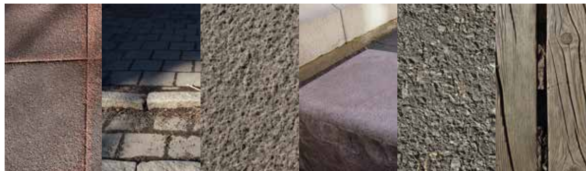
Bilde 63 - 68: ulike dekker og materialer i skolegården, f.v: 1) Fliser i myk gummibelegning under huske og klatrevegg. 2) Betong brukt på ramper og forhøyning. 3) Asphalt, 4) Kantstein til trapper og vannanlegg. 5) Kuber for å sitte på og for brettspill i granitt. 6) Tre i benker.
