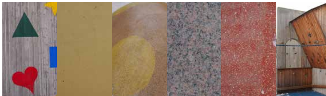
Bilde32- 37: Dekor på klatrevegg, Gummibelegning, positiv landskapsform i gummidekke, granitt benyttet ulike steder, Rød gummibelegning og klatrestruktur i tre.
