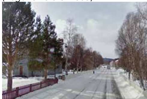
Bygdegate i Os i Hedemark. Utbedringer gjort på stedets premisserlaget, som en del av prosjektet "Fra vei til gate" Styrket identiteten og senket bilenes hastighet. ( Bilde 105)
