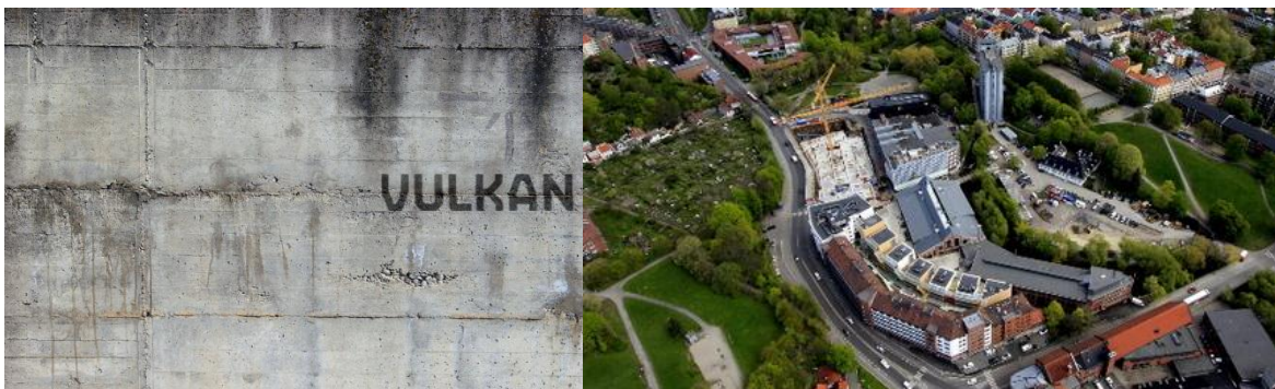
(Bilde 6: Betongvegg med påskrift og området fra sør i fugleperspektiv)
