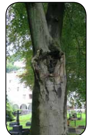
Bøk ( Fagus ) med skade i grenfeste.
