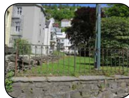
Smijernsgjerdet er montert på natursteinsmur mot Kong Oscars gate i sør.
