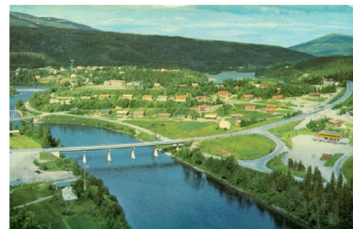
1975: Ny E6 sto ferdig med ny bro over Vefsna. Avløste Rv 50 som hovedveg nord-sør.
