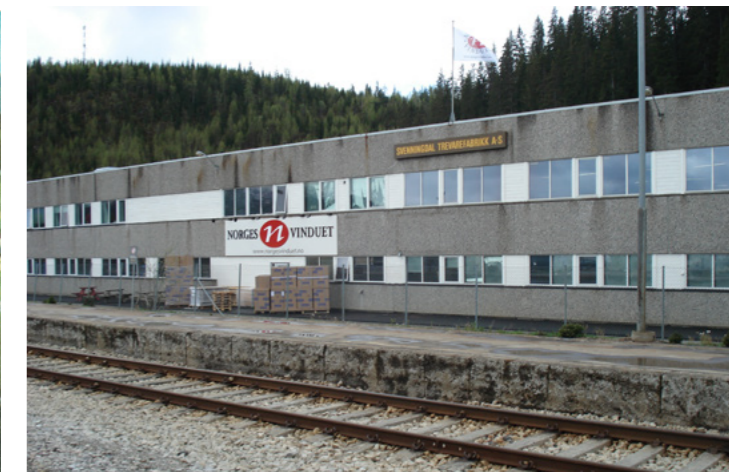
1982: Trofors Industribygg sto ferdig, og Trevarefabrikken kunne flytte inn under ett tak på Trofors igjen. Dette etter noen år med deler av produksjonen i Mosjøen grunnet for liten plass i eksisterende lokaler.
