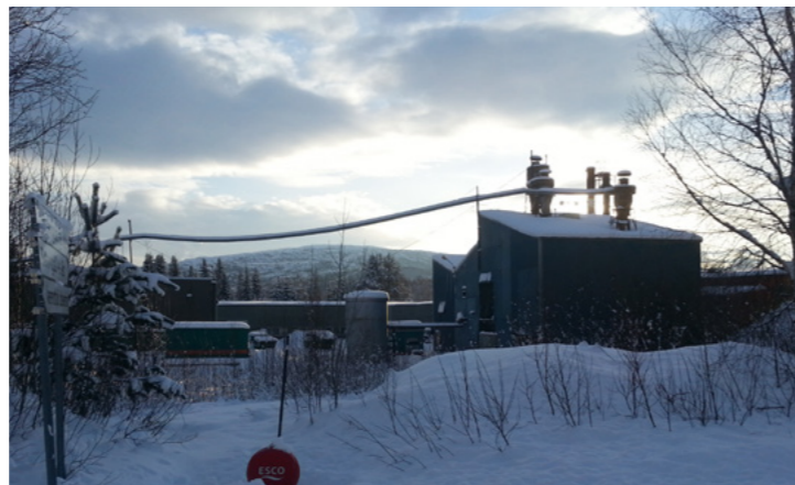
Det gamle fabrikkområdet, sett fra Industrivegen.
