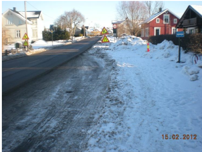
Bilde 57 skolevei 1 Barkåker. Bildet viser snøhaugen langs strekning 1.
