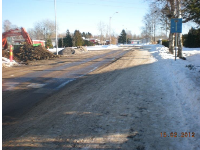
Bilde 59 Bildet viser arbeid langs veien langs Skolevei 2 på Barkåker.
