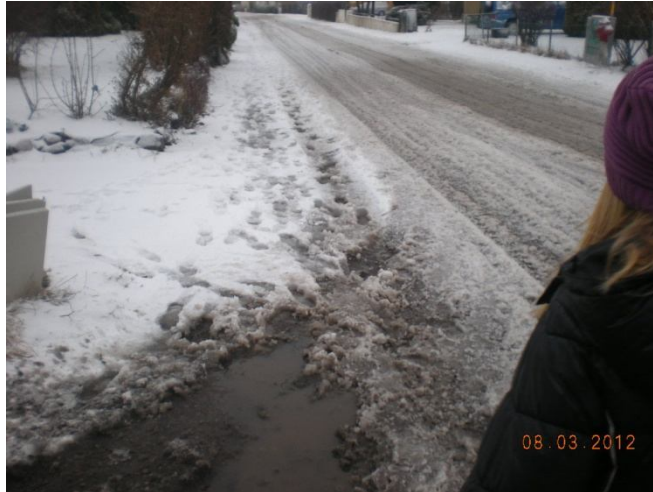
Bilde 36 skolevei 1 Træleborg. Hull i fortauet er fylt med smeltet snø
