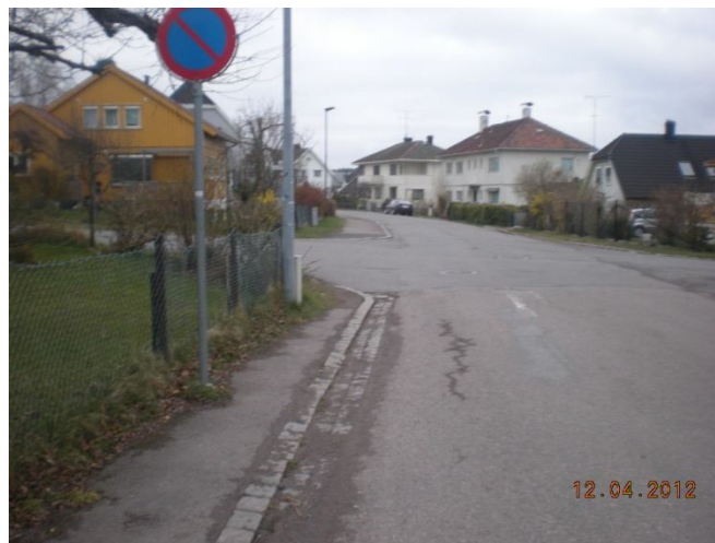
Bilde 32 Bilde av skolevei 1 viser et veldig smalt fortau
