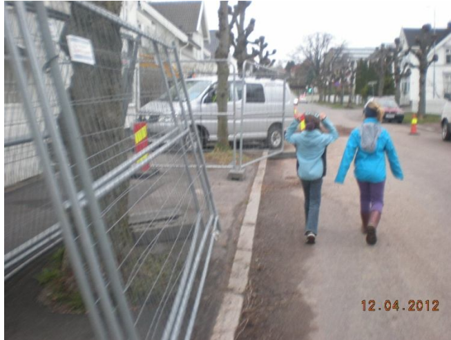
Bilde 33 skolevei 2 Træleborg. Viser arbeid i veien, elevene må gå i bilveien eller benytte fortau på andre siden.
