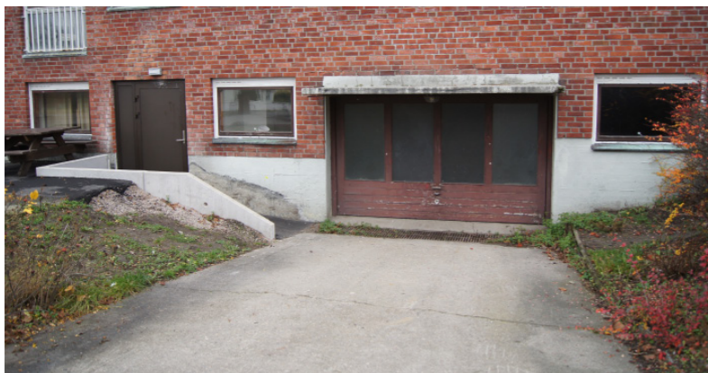
Vareleveringsrampen ned til kjelleren.
