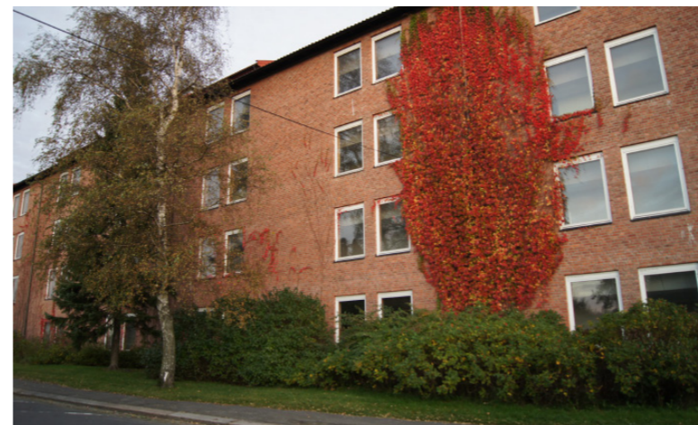
Store deles av husveggene er dekket av klatrevillvin. Dette er et spesielt vakkert syn om høsten da bladene blir rustrøde.
