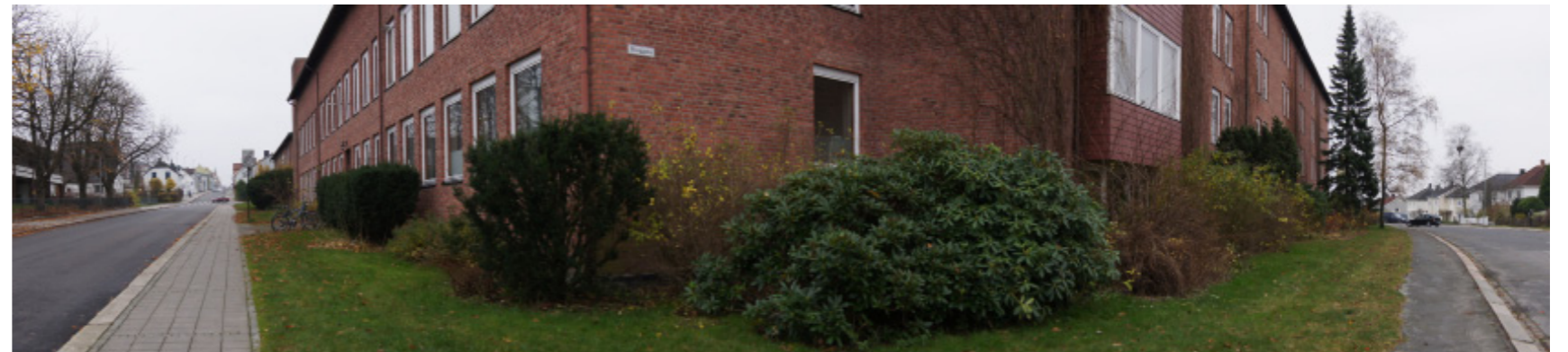
Panoramabilde over yttersonen langs skolebygningene.
