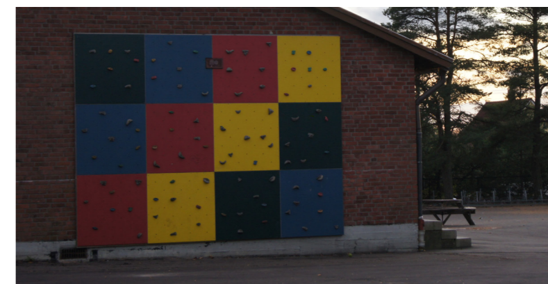
Klatreveggen er en av de nyeste aktivitetene som er installert.
