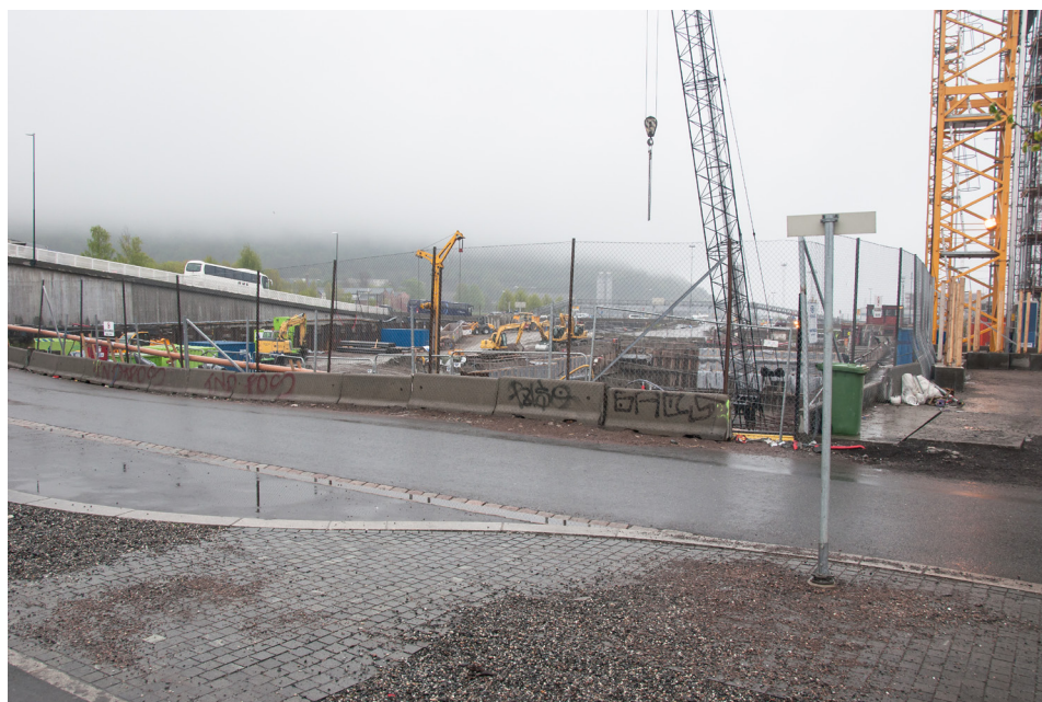
Figur 61: Slik ser foreløpig B13 ut. Arkeologiske utgravninger er i ferd med å avsluttes, og bygging kan snart begynnes. Foto: Aleksander S. Kristoffersen
