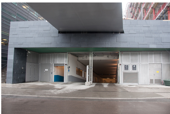
Figur 50: Nedkjøringen til felles parkeringskjeller for alle Barcode byggene fra Trelastgata rett under Stasjonsallmenning broa. Foto: Aleksander S. Kristoffersen
