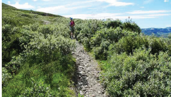
Fig. 18 Bildet viser eksempel på erosjon som er et stort problem på Kongevegen over Filefjell.
