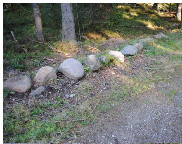
Nye stabbesteiner er lagt langs vegen ved siden av de gamle.
