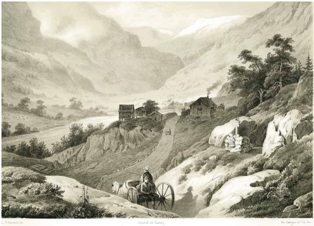
Fig 30 Rode stolpe til høyre for vegen i et motiv fra Galdarne.
