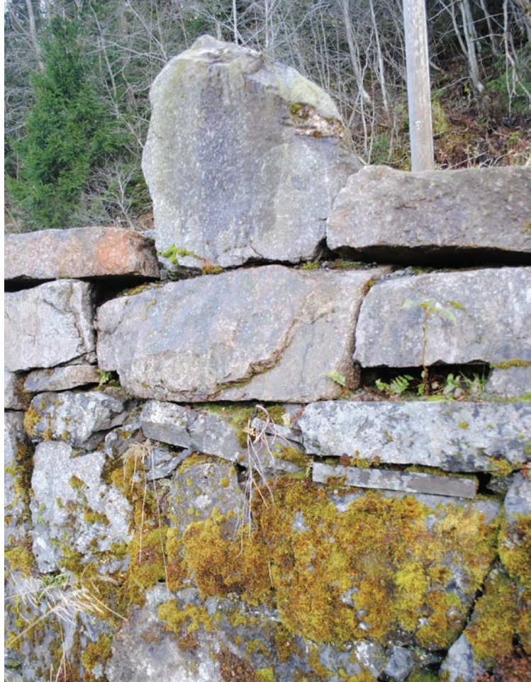
Bildet viser at istandsettingen er synlig.
