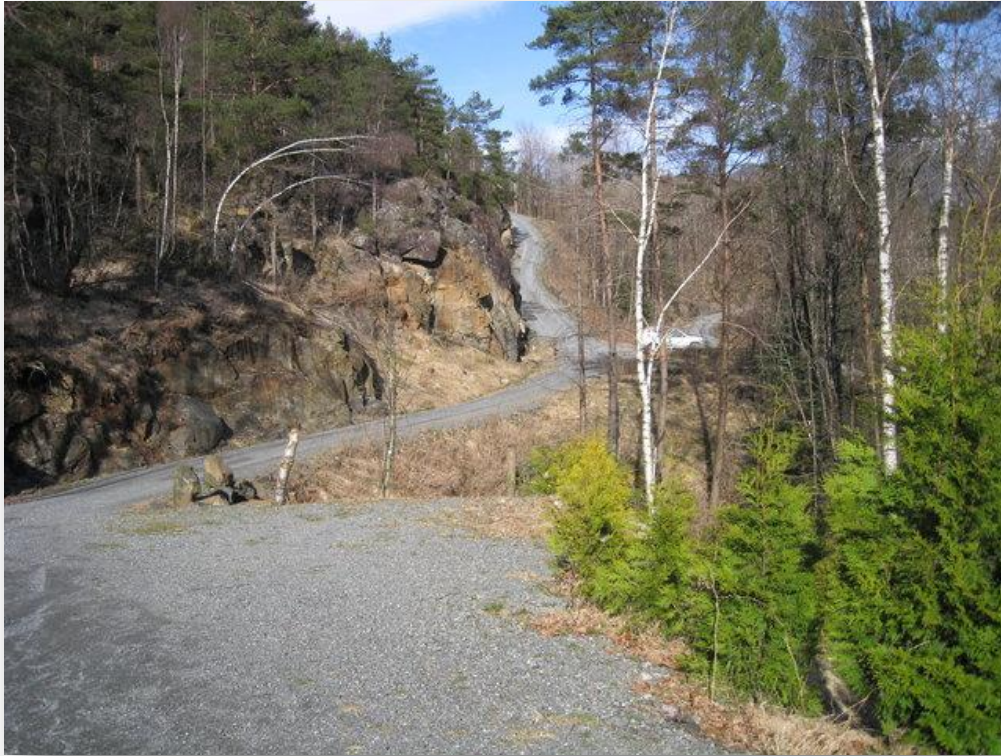
Figur 46: Veg A samt fellesvegane I og II på Storskjær.
