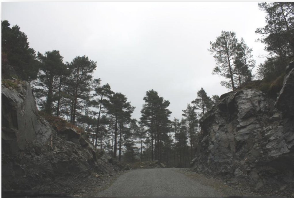
Figur 49: Fjellskjeringar etter sprenging på Flatråker.
