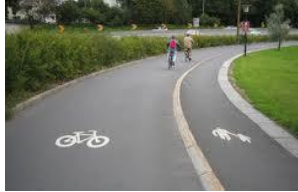
Bilde 10: Sykkelveg med fortau
