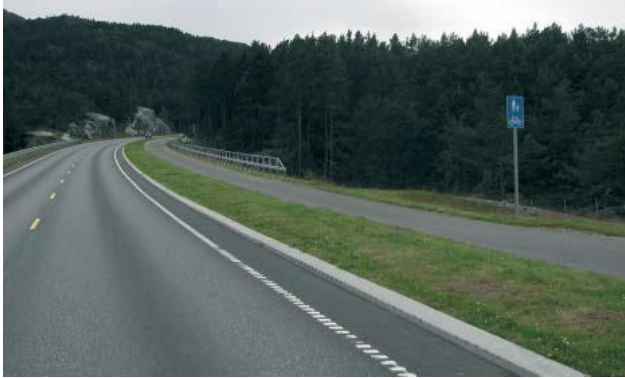
Bilde 9: Gang- og sykkelveg skilt fra kjørebanelen med rabatt
