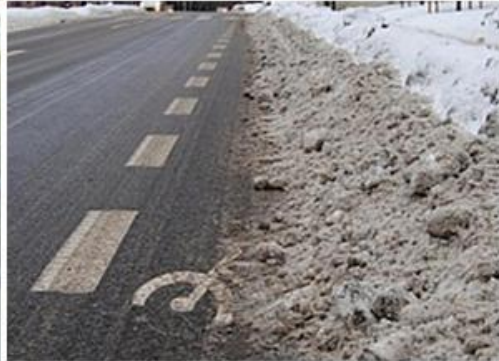
Bilde 15: Dårlig vedlikehold av snø på sykkelveg
