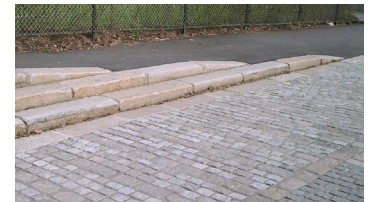
Eksempel på løsning av hvordan trapp møter terreng.
