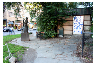
En dominerende trafokiosk bak skulpturen.
