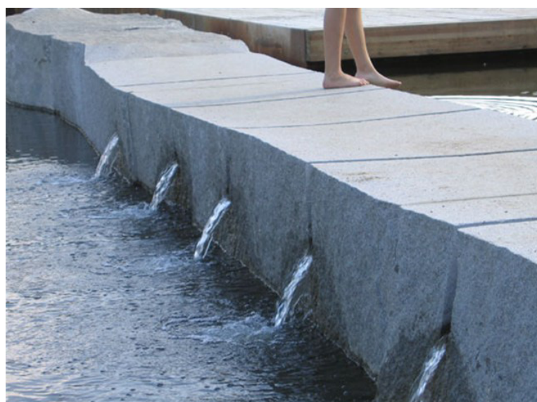
Figur 44 : Overløpsdemning som kunstnerisk element. Bilde fra prosjekt i Alnavassdraget i Trondheim kommune.
