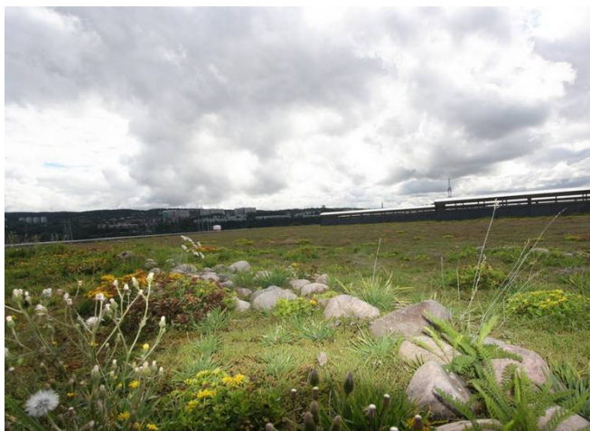
Bilde 6 : Nordens største grønne tak anlagt på Veolia sitt miljøanlegg i Groruddalen.
