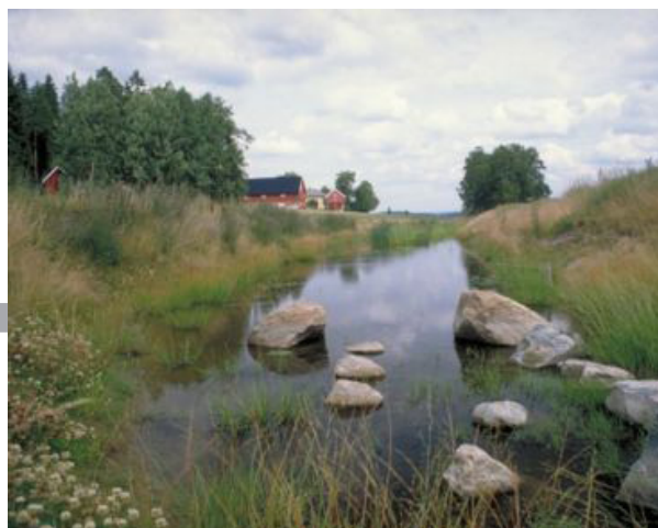
Bilde 17 : Konstruert våtmark i form av fangdam anlagt i dyrket mark som rensende og estetisk element. Naturlike formprinsipper
