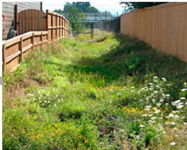
Bilde 14 : Naturlik gresskledd forsenking (swale) for infiltrasjon, rensing og fordrøyning av overvann
