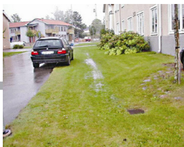
Bilde 5 : Gressdekte forsenkinger i sideterreng til boliggate. Vann infiltreres på stedet.
