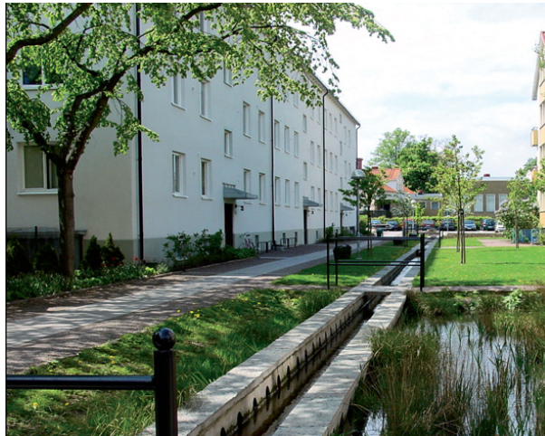
Bilde 10 : Stram vannvei som leder overvannet til fordrøyningsvolumer i Ekostaden Augustenborg, Malmö
