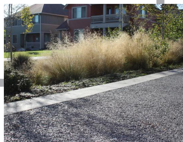
Bilde 4 : Permeabel asfalt på gangfelt og swale (grunn vegetasjonsdekket veggrøft). Begge elementer infiltrerer og fordrøyer.
