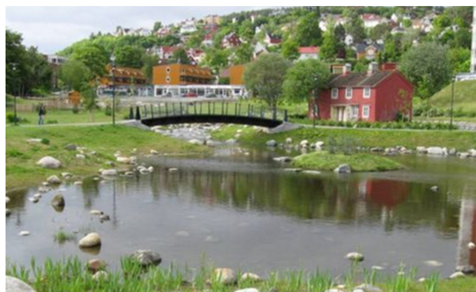
Figur 58 : Gjenåpning av Ilabekken i Trondheim. Dammer med tråkkesteiner og steiner i bekkeløpet forøvrig bremser vanntransport og kan innby til opphold og lek. Kilde: http://www.naturmangfoldaret.no/historier/statens-bymiljopris/
