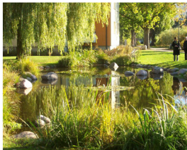
Bilde 15 : Dam for oppsamling og fordrøyning av overvann i Augustenborg. Kant- og vannvegetasjon og tilfeldige tråkkesteiner gir et noe mer naturlig preg
