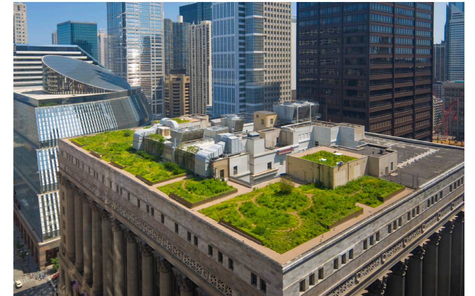
Illustrasjon nr. 18. Grønt tak på Chicago City Hall i Chicago, USA. Vegetasjonen har bidratt til at byggets energikostnader har blitt 11% mindre. Brukt med tillatelse fra City of Chicago / GRC.
