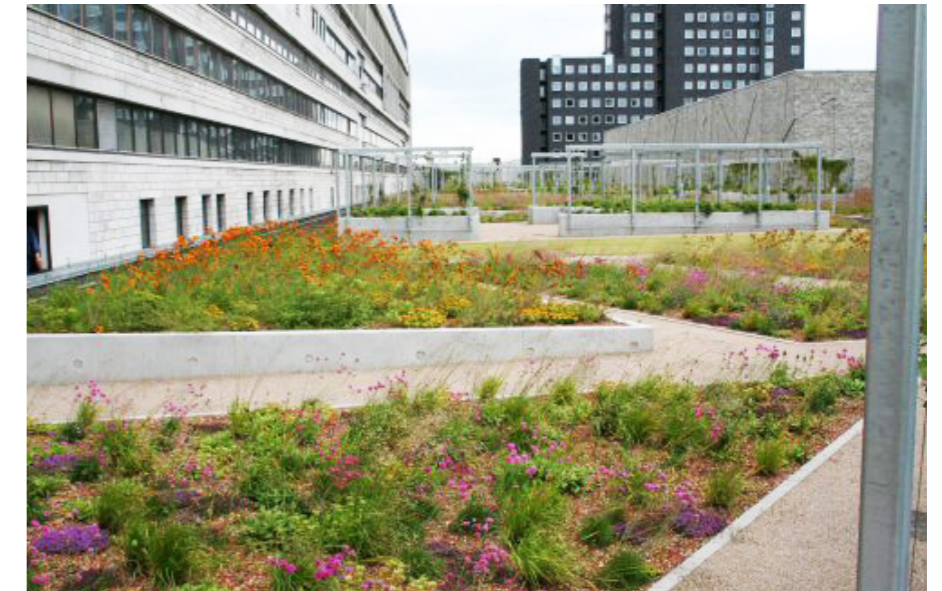
Illustrasjon nr. 52. Det semi-intensive grønne taket på Kalvebod brygge. Beplantningen blomstrer vakkert. Brukt med tillatelse fra Schønherr Landskab.
