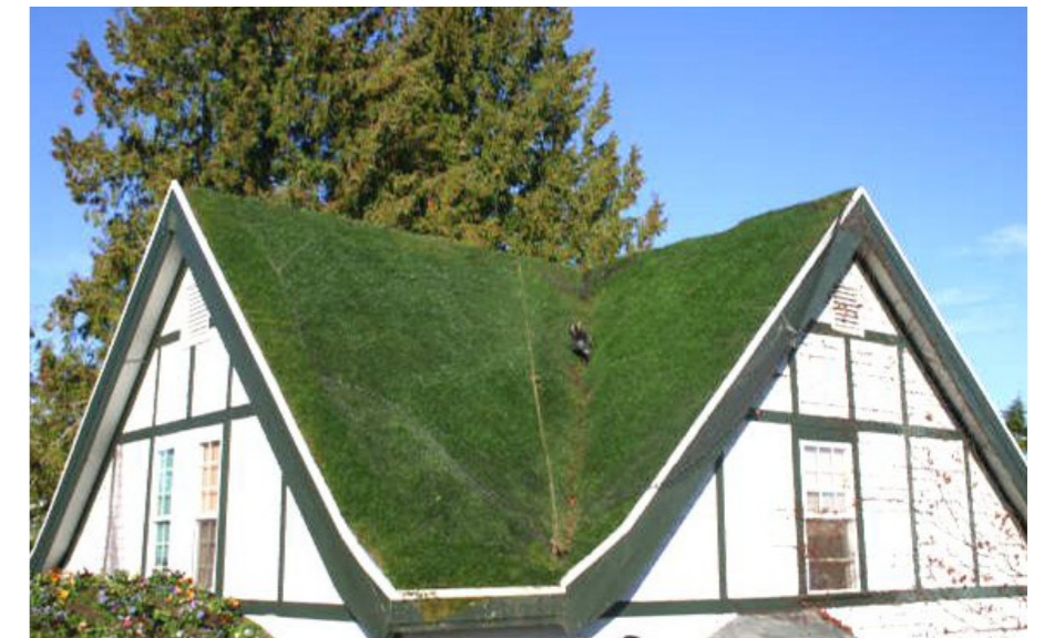
Illustrasjon nr. 45. Mose på privat hus. Prosjektet er kalt Troy's Green Roof og anlegget befinner seg i Tacoma i USA.
