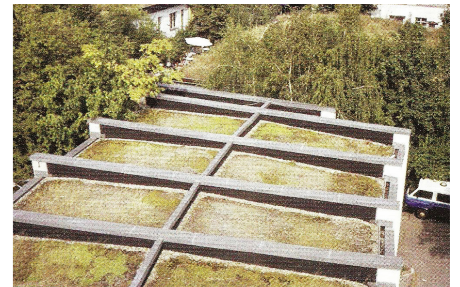
Illustrasjon nr. 19. Grønne tak øker levetiden på takbelegget. Dette grønne taket ble anlagt på 1920-tallet i Berlin i Tyskland. Brukt med tillatelse fra CIRIA.
