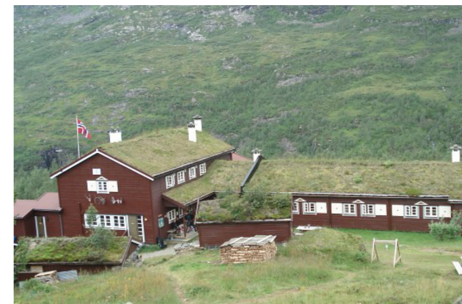
Illustrasjon nr. 8. Grønt torvtak på fjellhytte i Jotunheimen i Norge. Brukt med tillatelse fra Kjell Arvid Stølen.
