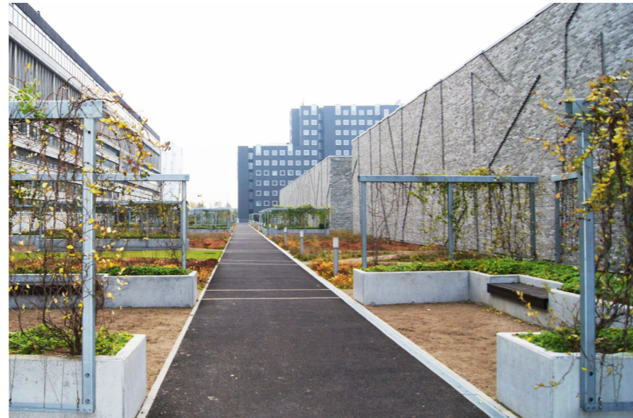
Illustrasjon nr. 51. Det semi-intensive grønne taket på Kalvebod brygge. Dette bildet viser hovedstien gjennom parken, noen av plantekassene, benker og to av pergolaene med klatreplanter.
