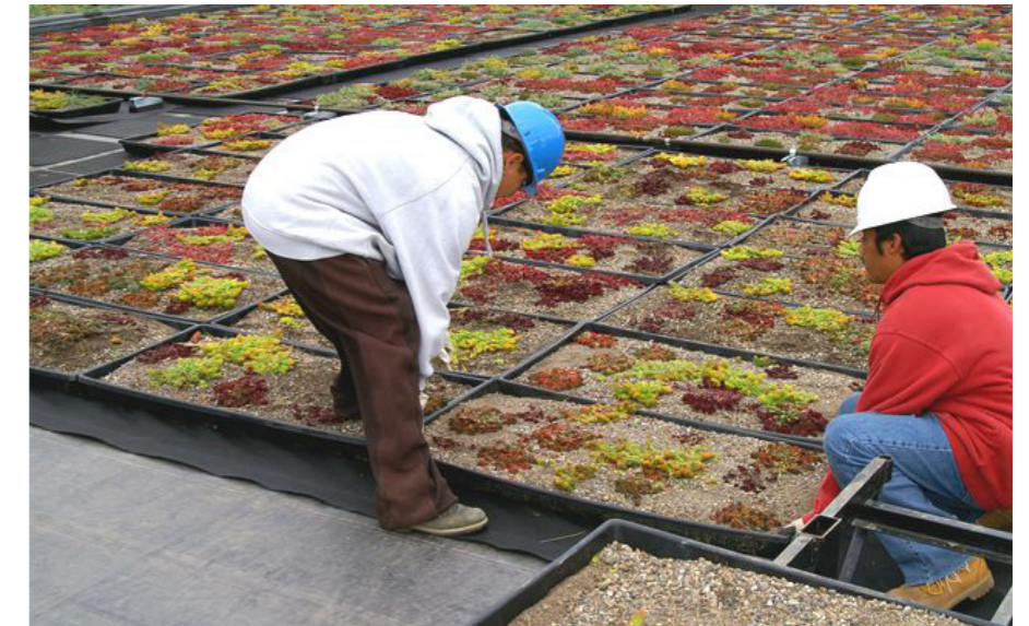
Illustrasjon nr. 44. Et eksempel på moduler som planteetableringsmetode. Bildet er fra The Court at Upper Providence Shopping Mall i Royersford i USA.
