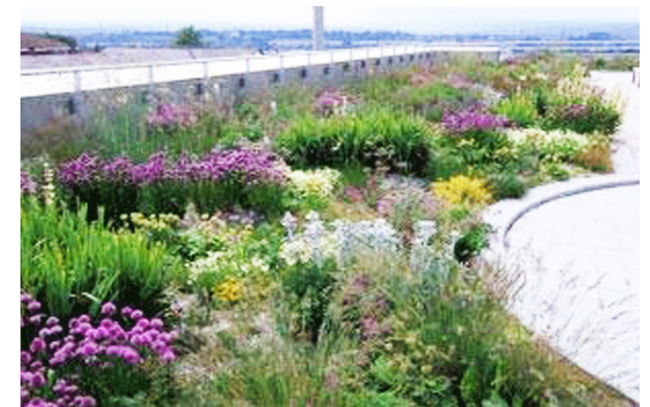
Illustrasjon nr. 28. Semi-intensivt grønt tak på Moorgate Crofts Business Centre i Rotherham, Storbritannia. I følge Dunnnett & Kingsbury (2008) er taket estetisk og har et høyt nivå av biologisk mangfold, selv uten vanning og gjødsling.
