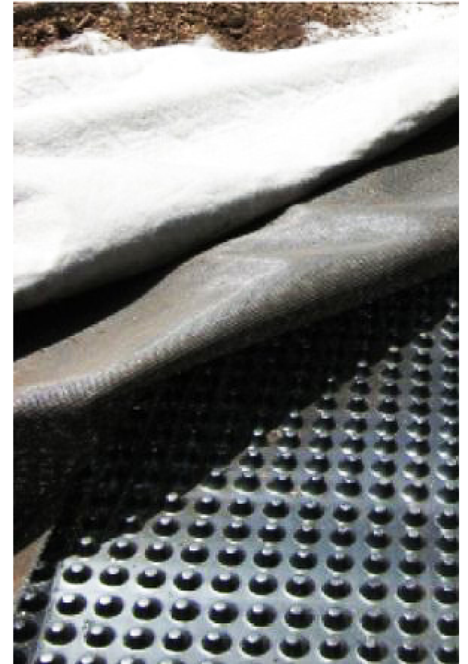
Illustrasjon nr. 23. Oppbygningen av et grønt tak består av flere ulike komponenter.
