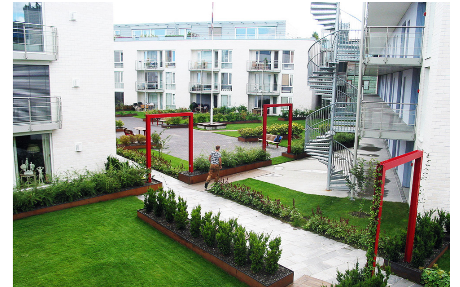
Illustrasjon nr. 5. Intensivt grønt tak på Thaulowkaia i Trondheim. Brukt med tillatelse fra Arvid Ekle.
