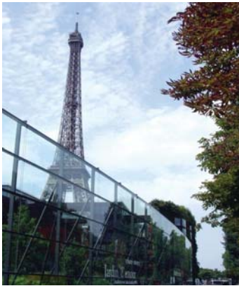
fig 2.104 Støyskjerm som i tillegg er brukt som et estetisk element, Quai Branly i Paris.
