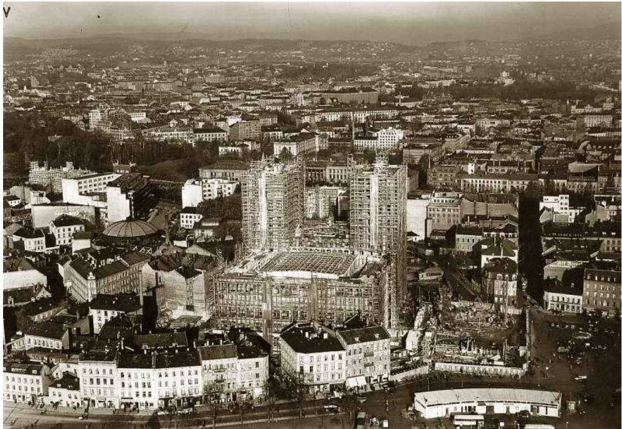
Rådhuset under bygging i Pipervika i 1935. Tidligere bygårdsbebyggelse synes i forgrunnen.
