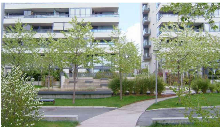
Bilde 129 og 130: Søkirsebær og vintereik er brukt rundt den felles oppholdsplassen og ytterkanten i Marienlyst Park der det ikke er parkeringskjeller under.
