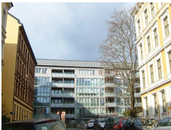
Bilde 78: Klosterenga økologiboliger sett fra Schweigaards gate.
