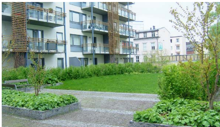
Bilde 59: Et av hovedrommene i anlegget.
