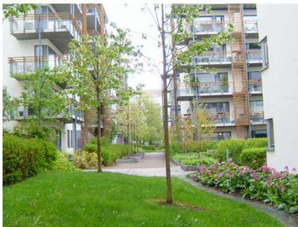
Bilde 58: Intern gangvei i anlegget
