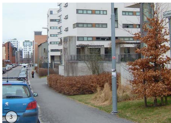
Bilde 42: Marinelyst Park sett fra Gydasvei i sørøst.
