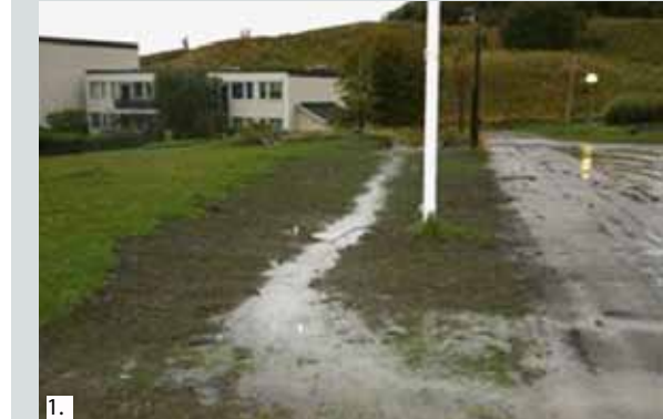
1. Vannet renner inn i anlegget via en gresskledd forsenking i terrenget langs ballplassen.
