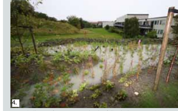
4. Regnskylllet er så stort at regnbedet fylles helt opp med vann.
