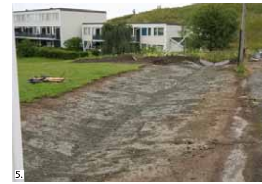
5. Grovt lager vei for overvannet fra ballplassen til regnbedet.
