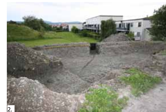
2. De stedlige, leireholdige jordmassene fjernes.
