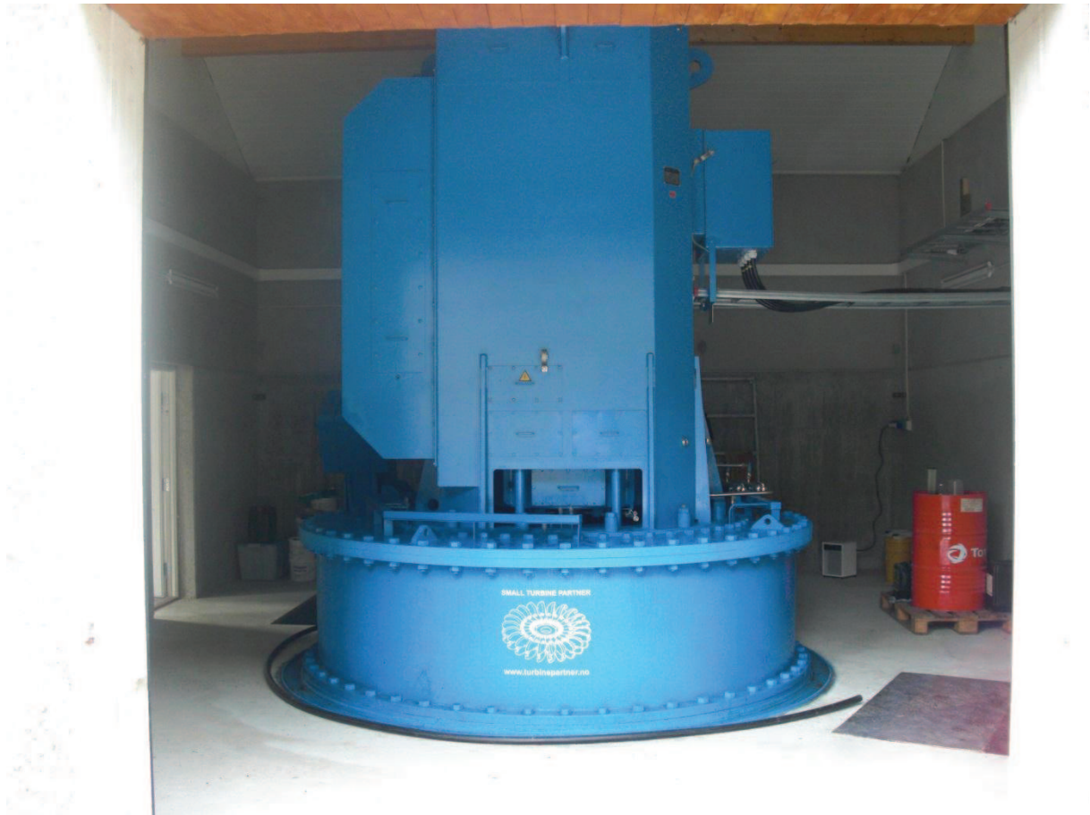
Figur 3 syner den installerte turbinen i kraftstasjonen til Vika kraft, (eige foto).
