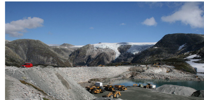
Under utbygging av Kjøsnesfjorden kraftverk Bilde fra http://www.bygg.no/cache/image/8435/53/verdensrekord-dam.jpg
