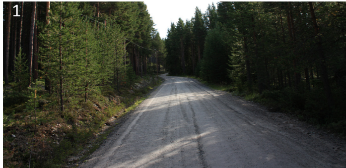
1 Ved avkjørselen mot Tron går veien gjennom tett og karrig furuskog. Veien er tidvis meget bratt.
