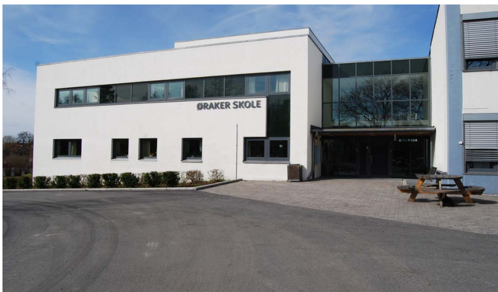
Figur 14. Øraker skole med inngangsparti. Bygg til venstre ble nybygd i totalrehabiliteringen og er personal- og administrasjonsblokk. Trinnfri adkomst fra parkeringsplass.
