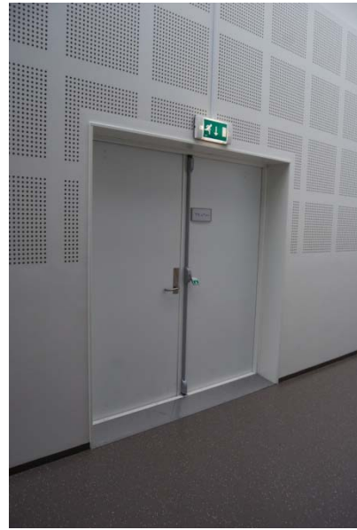
Figur 13. Vanlig dør. Ikke i kontrast til veggen rundt. Skiltet som viser rommet er heller ikke godt synlig før man kommer nærme. Vegg og dører bør være i kontrast.
