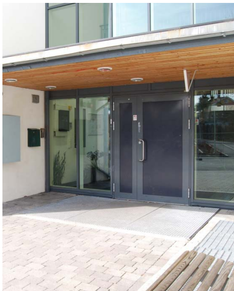
Figur 15. Inngangspartiet. Ikke elektrisk døråpner, samt høy terskel gjør at personer i rullestol vil kunne få problemer.
