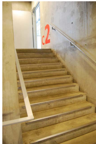
Figur 33. Trapp uten markeringer. Håndlist i dårlig kontrast til vegg. Pluss for sammenhengende hele veien, men lett å hekte i da den ikke er avrundet. God og tydelig markering av etasje.
