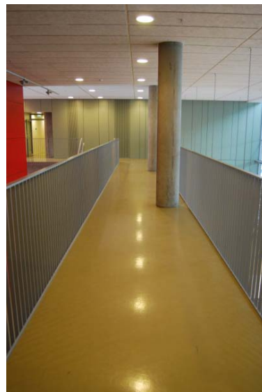
Figur 31. Korridor som blir smal grunnet umerkede søyler.
