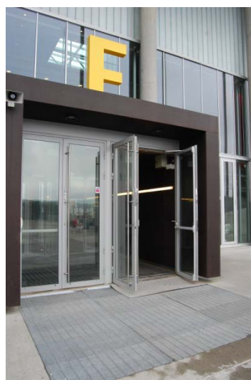
Figur 25. Inngangsparti. Bred dør med elektronisk åpning. En del ujevnheter med terskel kan skape problemer.
