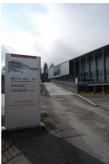
Figur 24. Adkomstvei. Godt utformet og lesbart skilt. Rampen er for bratt.
