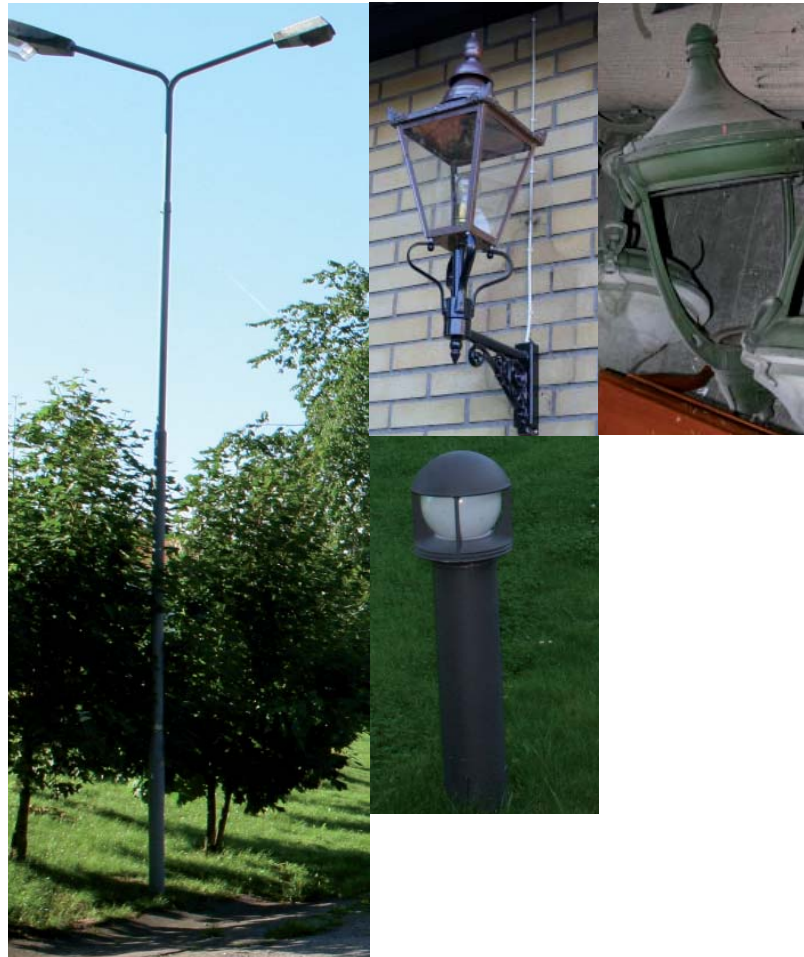
Belysning av varierende karakter bidrar til at anlegget får et lite helhetlig inntrykk.
