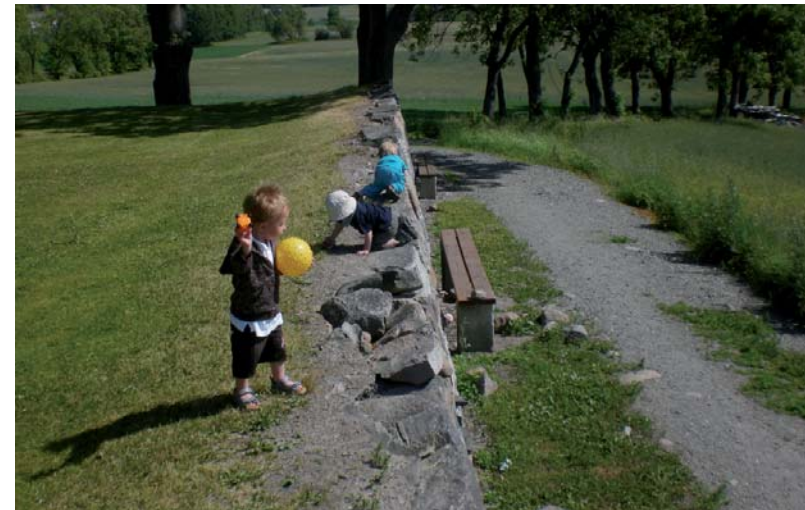
Oppmurt aha - den subtile høydeforskjellen inn mot hagen oppdages ved nærmere ettersyn (Persvik).
