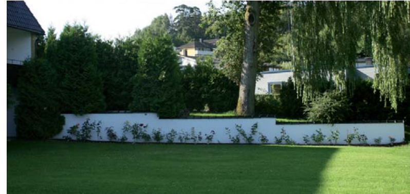
4. Terrengforskjell tatt opp av nyere "spansk" mur i vest
