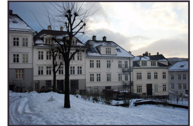
Bygningsrekke langs Søndre Allmenning
