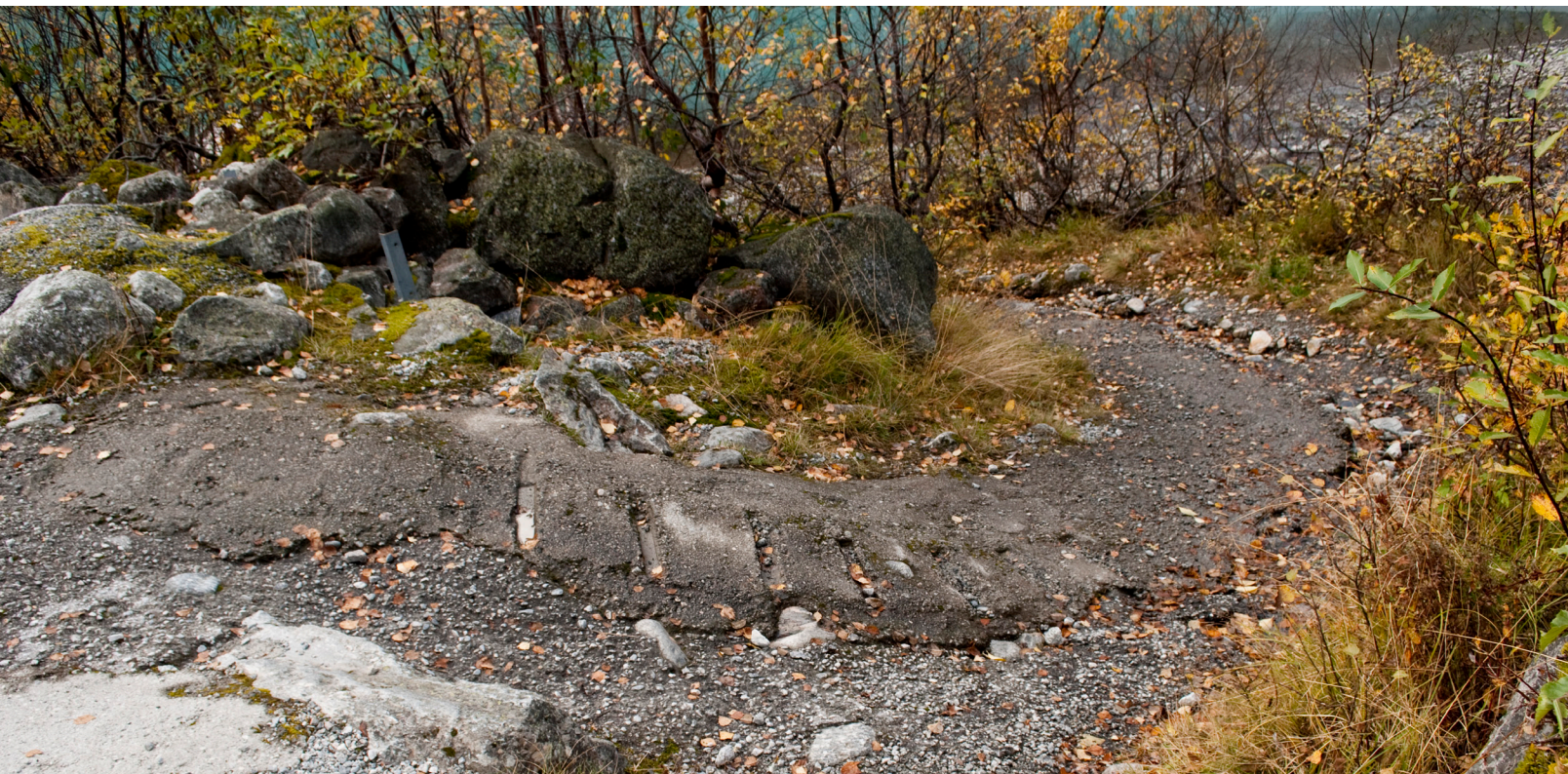
Betongdekke for å hindre erosjon
