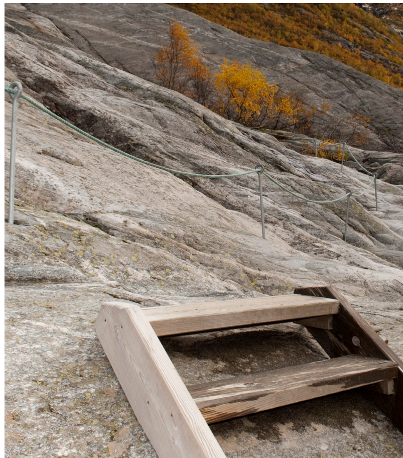
Trapp, og boltar med tau for å halde seg i og lette tilgjenge.
