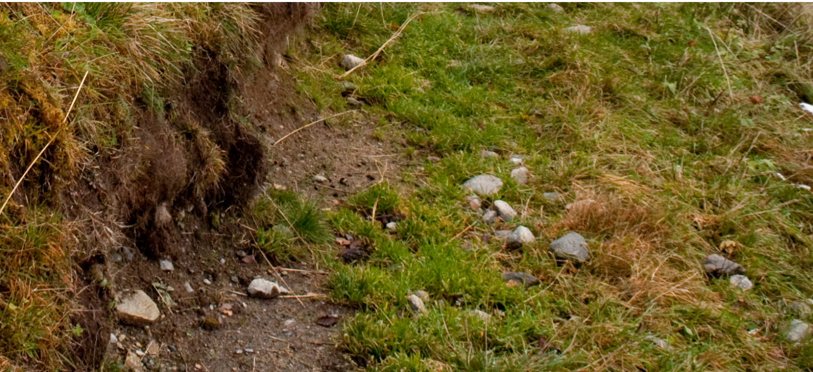
Sti på ustabil grunn, utrasing av jord.
