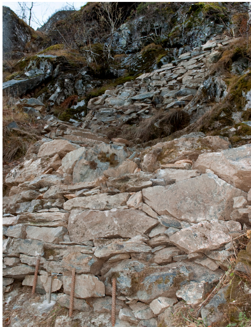
Muring og steinsetjing av sti.
