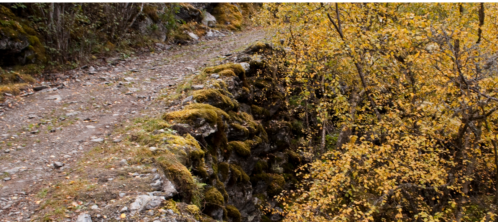
Gammel mur som støttar opp skogsveg som leier til sti opp til gammel støl.
