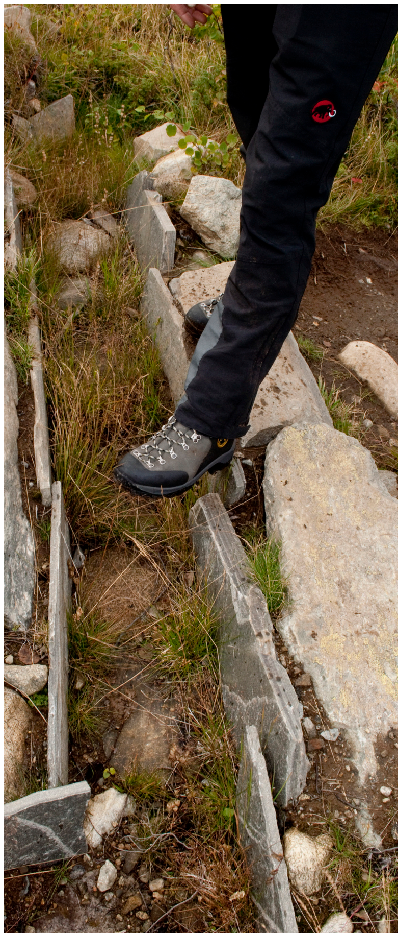
Dreneringstiltak for å leie vatn ut av stien.
