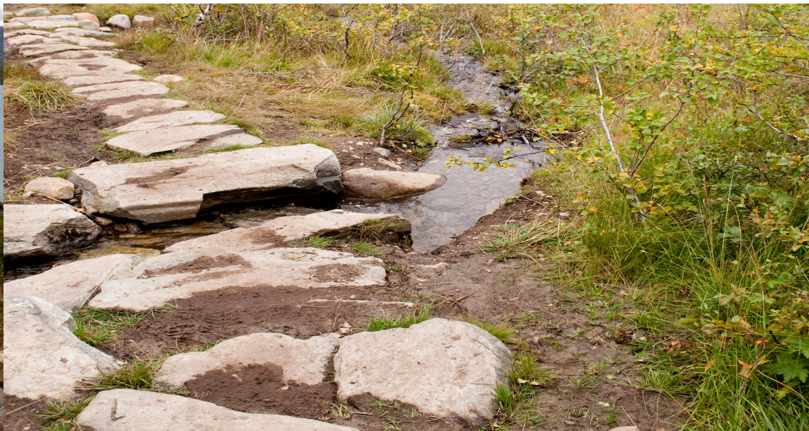
Steinsetjing gjennom blautt område med kanalisering av bekk.
