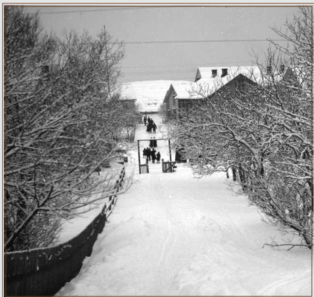
Aksen ned fra presteboligen til sjøen rundt 1920. Man kan se helt ned til sjøen fra presteboligens hovedinngang. Foto: Ole Andersen Brønnø, utlånt av Brønnøy historielag
