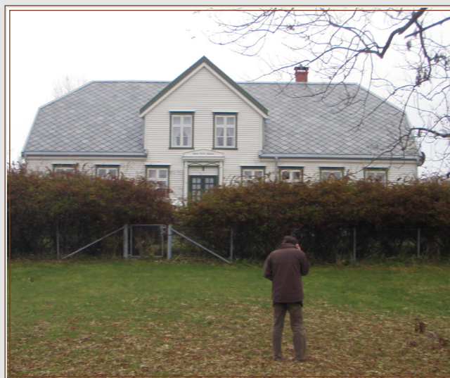
Opp mot presteboligen slik det ser ut i dag. Presteboligen er innrammet og aksen opp mot huset har blitt avskjært. Foto: Eget bilde, oktober 2009
