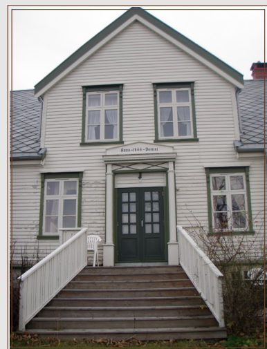
Inngangen i dag. Foto: Eget bilde
