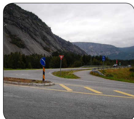
11. Problemområdet hvor gang- og sykkelvegen går rett ut i fylkesvegen og hvor det ikke er fotgjengerovergang.
