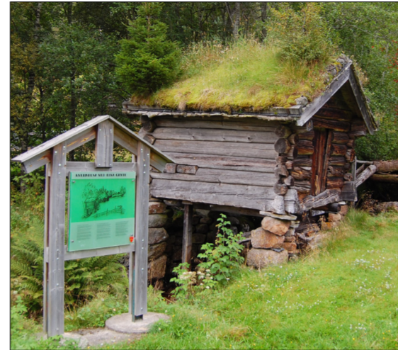
Bilde 2: Informasjonsskiltet til Kvernhusvegen tursti. Treverket glir fint inn i naturmiljøet. Etter flere år ute er treverket blitt grålig. De støpte betongelementene kunne vært gravd lenger ned i bakken, slik at de dekke med jord og gress kom over. Det vil se penere ut.
