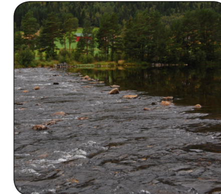
19. Steinterskel. Denne terskelen er bygget opp av stein, slik kan fisken passere og svømme videre opp i elven. Her er elven grunn.
