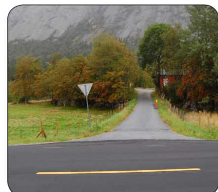
13. Ingen overgang til hengebroen. Gang- og sykkelveg fører ut til RV9, ingen trygg overgang over veien.
