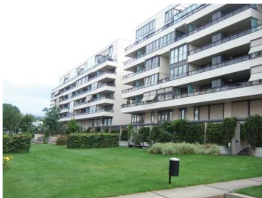
Fasader mot det sentrale uterommet
