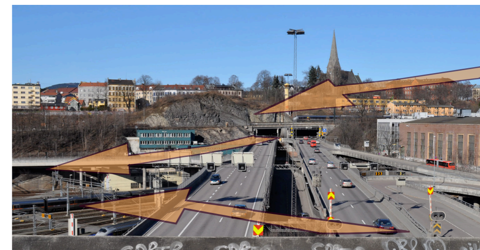
Riksvei 190, Konowgate over munningen til Ekeberg tunnelen* Lodalsbroene leder inn i Vålerengatunnelen. Hovedbanen med toget går over tunnelåpningen og Galgebergforbindelsen under. Lufforurensingen siger nedover Lodalen. Os fra både fra tunnelutløpene og tilsig fra Groruddalen.
