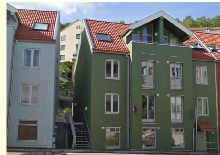
Moderne variant av trehusbebyggelse i Konows gate
