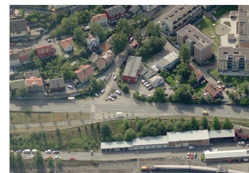
Instabilt område: Bakerenga Riggområde
