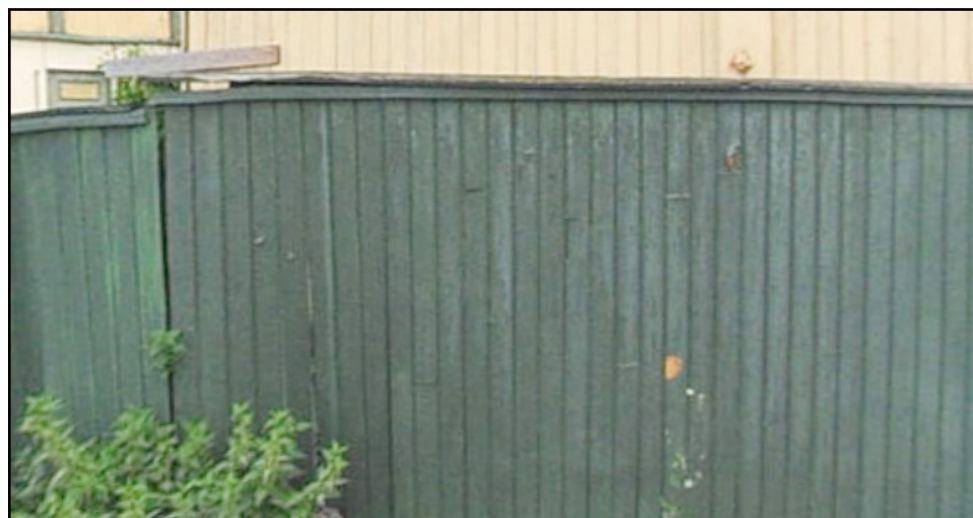
Inngjerdinger utført i stående trepanl. Som regel forekommer de i høyder som avverger innsyn fra passerende.
