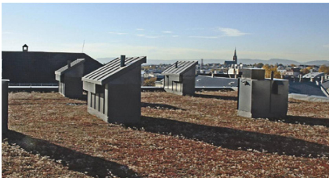
Figur 2.3: Eksempel på bruk av grønt tak fra Pilestredet park i Oslo. (Landskapsarkitekt Ådne Svalastog.)
