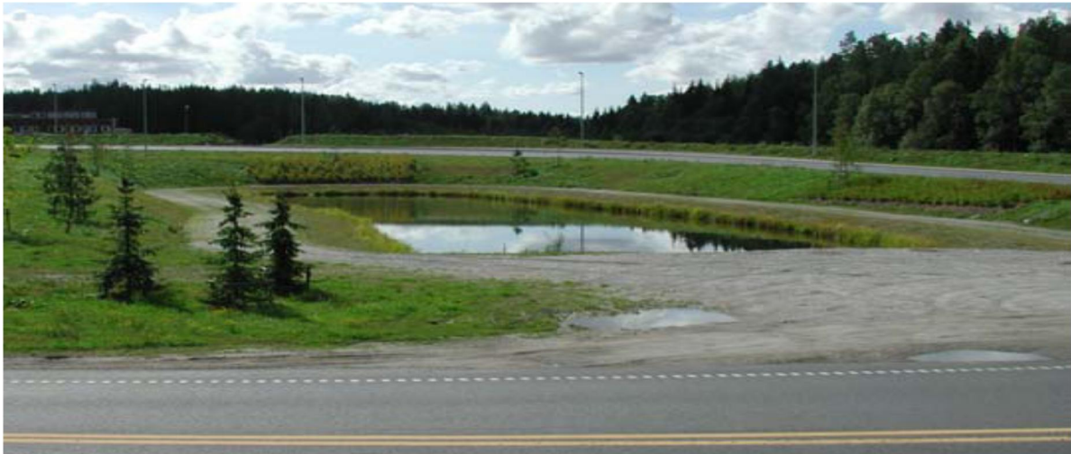
Figur 2.5: Rensedam for behandling av overvann fra veg, E6 i Ski kommune (Foto: Roger Roseth)
