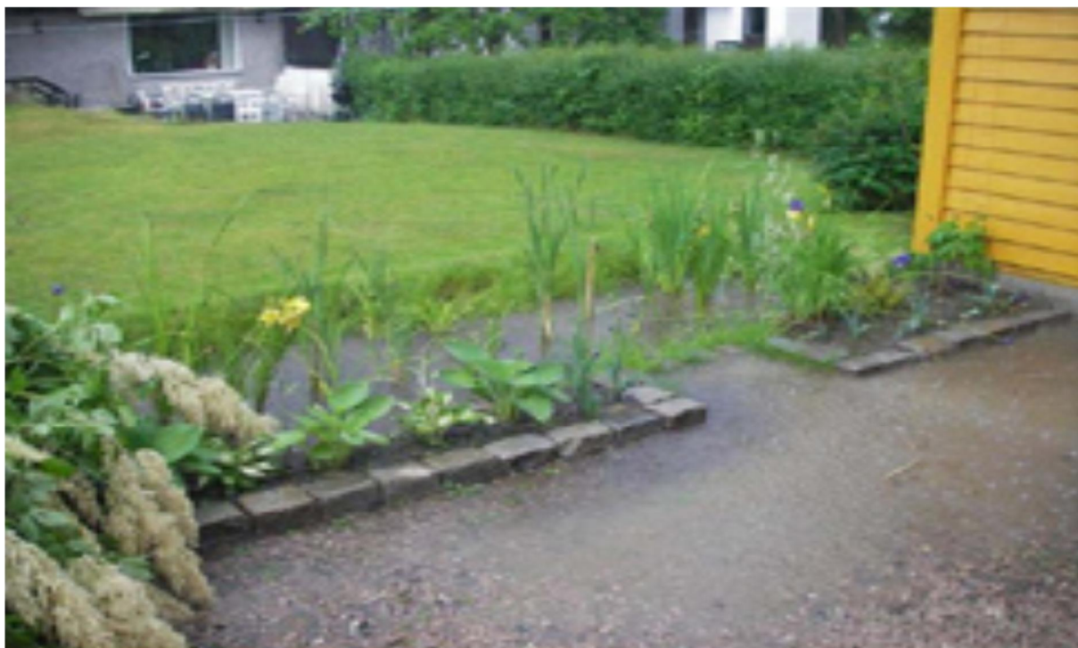
Figur 2.4: Et lite regnbed som mottar vann fra gårds plass i Nordre Aker, Oslo. Alt vann var infiltrert 10 timer etter regn. (foto: Bent C. Braskerud).
