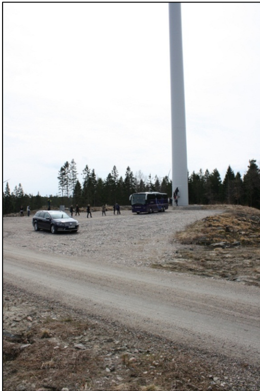
Figur 8 - Tårnet til vindturbin og oppstillingsplass, Lilla Edet, Sverige. Foto: Henrik Langbråten
