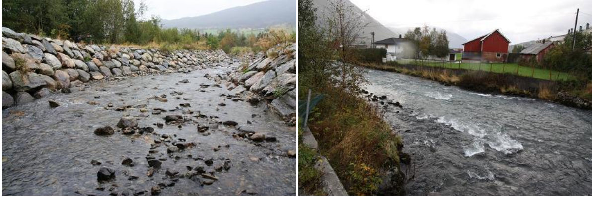
Figur 11. Myklebustdalselva stasjon 2 (venstre) og stasjon 3 (sett ovenfra), nedenfor utløpet av Byrkjelo kraftverk (høyre). Foto: Wendelbo 2010
